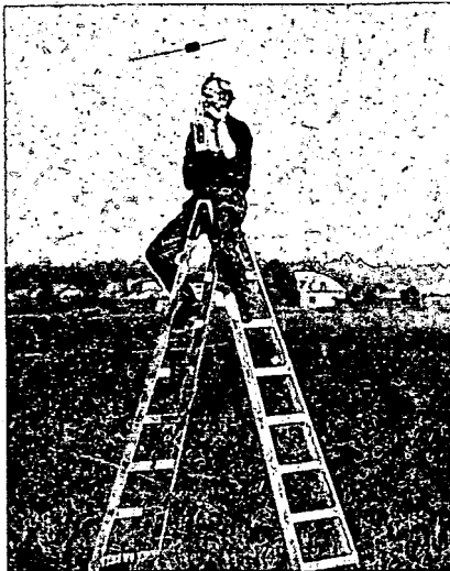
Obr. 2. Měření šíření VKV na volném prostranství (přijímač: měřič pole a rušení)
